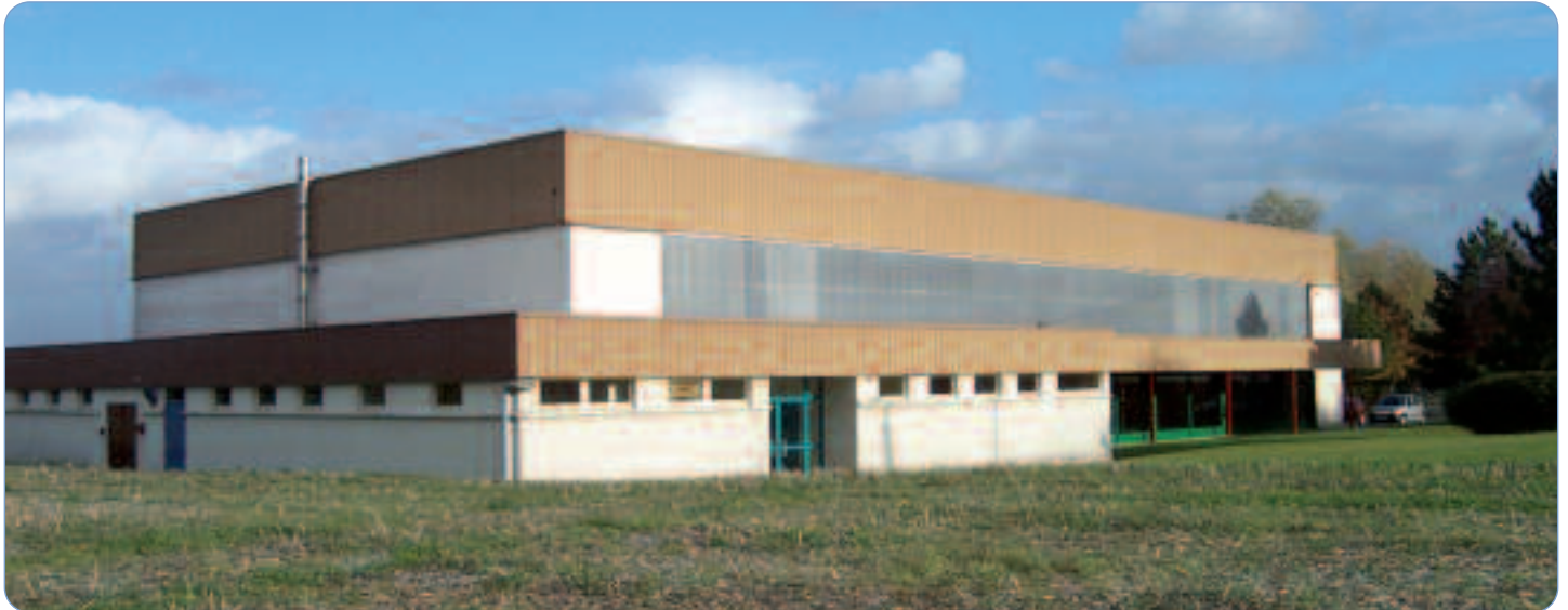
Gymnase Marcel Pagnol à Betz
