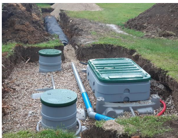
Assainissement non collectif composé d'une filière compacte et de tunnels d'infiltration
