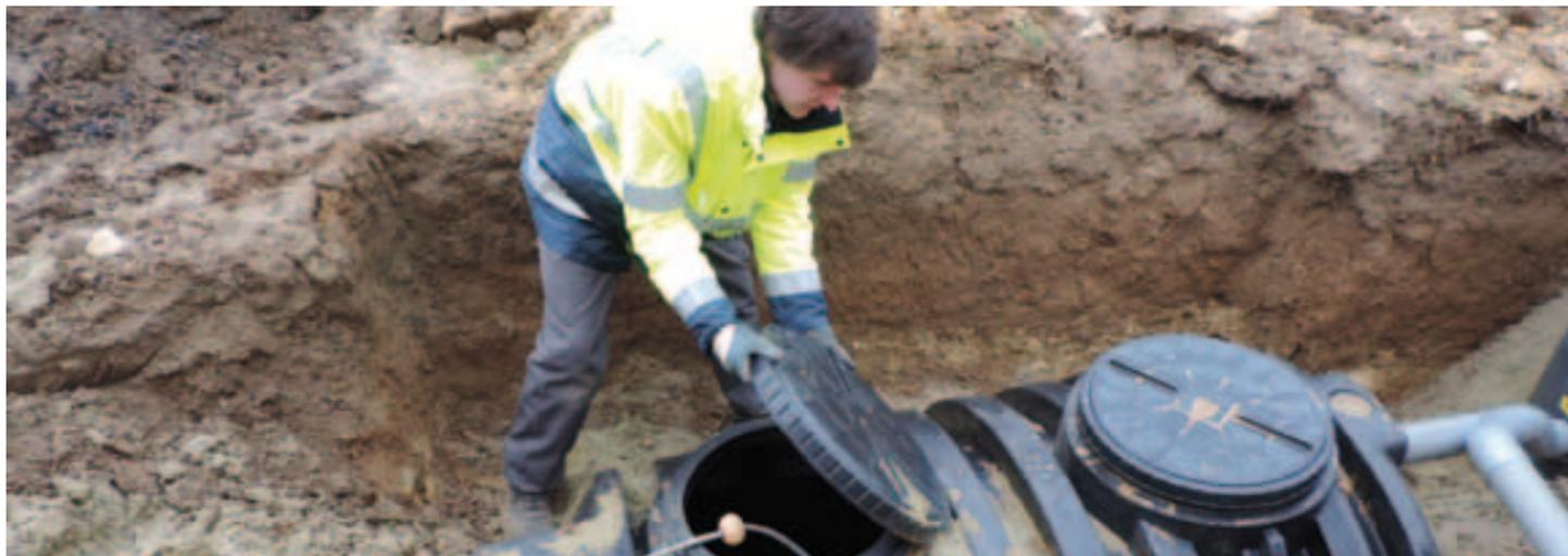
Le technicien SPANC réalise un contrôle de bonne exécution des travaux d'assainissement non collectif
