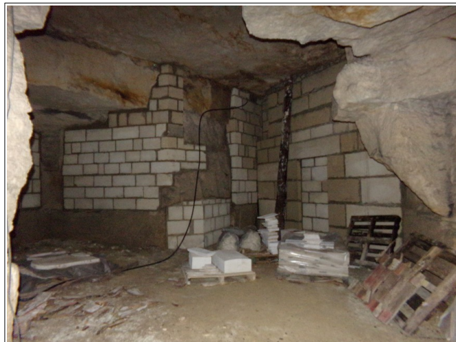
Figure IX.7: zone murée au fond de la salle 2 (comblement sous la rue de la Croix-Rebours).
