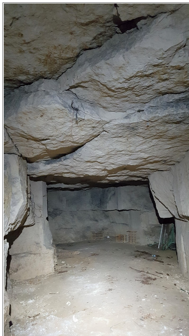
Figure XXXII.4: int rieur de la cavit  32 ; fissuration et d collement au niveau du ciel.
