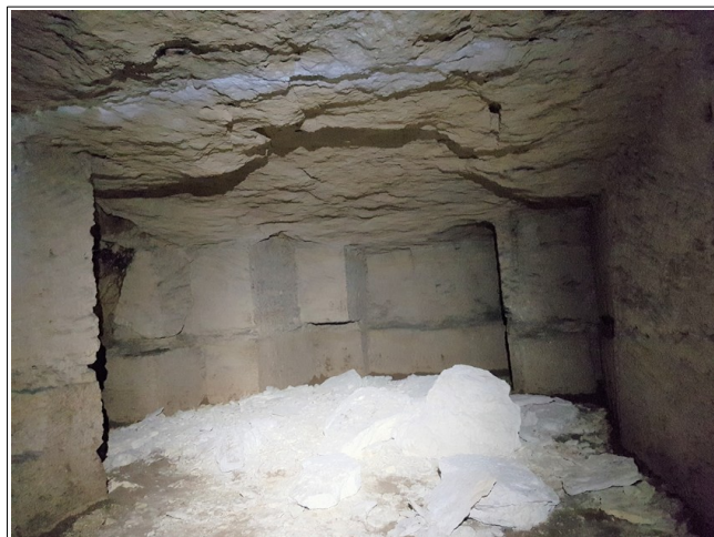
Figure XIX.6: chute de toit r cente au niveau du secteur 2.
