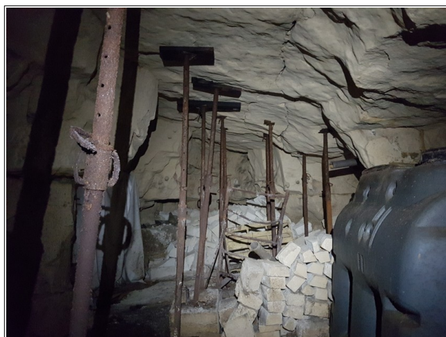
Figure IV.4: autre vue de la salle 2 et du fond la salle 3. Une fissure g ologique du ciel est visible.
