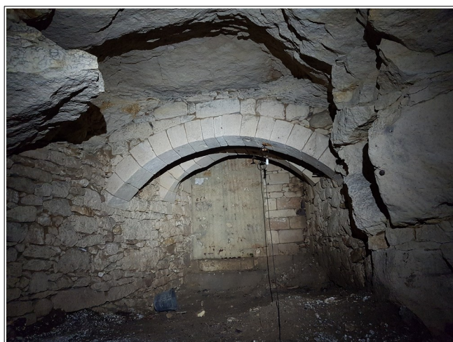
Figure I.5: intérieur de la salle 2. On notera les arches de soutènement, la cloche de fontis à l'avant des arches et la zone murée au fond (partie effondrée volontairement sous la parcelle 302).
