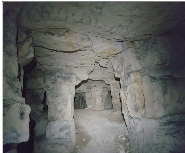
Figure III.13: grande cavité exploitée selon la technique des chambres et piliers (cavité 45).
