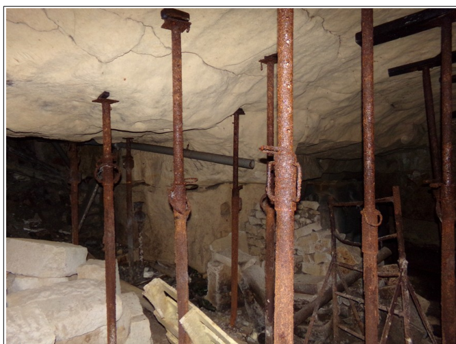
Figure IV.3: vue g n rale de la salle 2. Le ciel est  tay  sous la parcelle 259 o  stationnent des v hicules.
