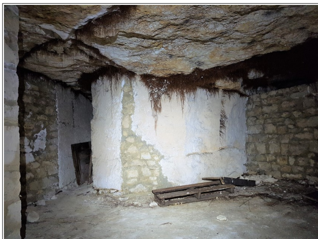
Figure XI.3: vue de la salle 1. On notera les racines traversant le cerveau de la cavité.
