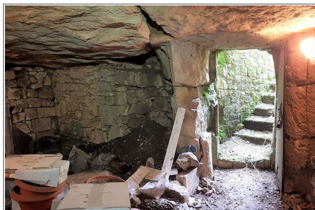
Figure XXXIV.3: int rieur de la cavit . Le mur en pierre contient probablement un remblaiement condamnant une ouverture (parcelle 110).
