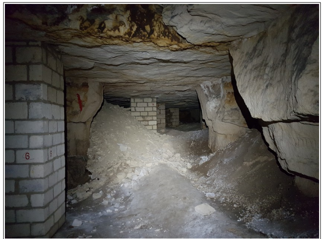
Figure VIII.10: vue générale de la salle 6 et de ses piliers de confortement. A ce niveau, le ciel présente des fissures mécaniques.
