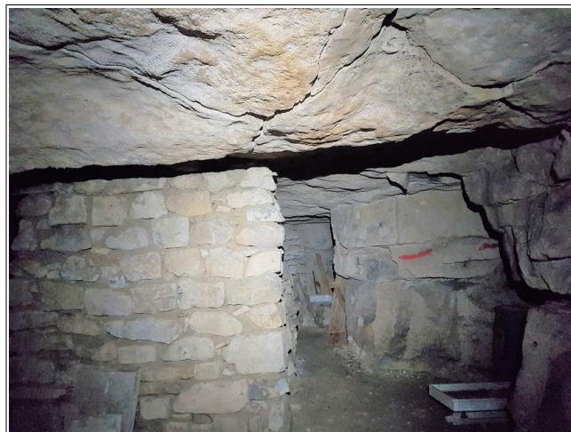
Figure IX.9: pilier en pierres maçonnées de la salle 3. On notera l'aspect dégradé du ciel.
