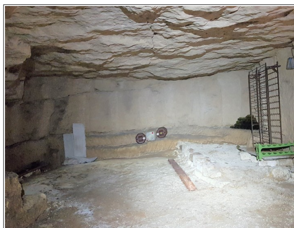
Figure XL.4: int rieur de la salle 2. On distingue une fissure au niveau du ciel.
