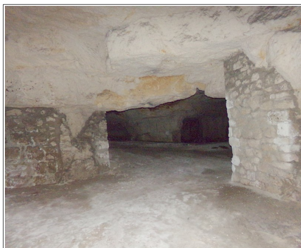
Figure XX.2: int rieur de la cavit  20 (vers l'entr e). On notera les piliers ma onn s (renforts).
