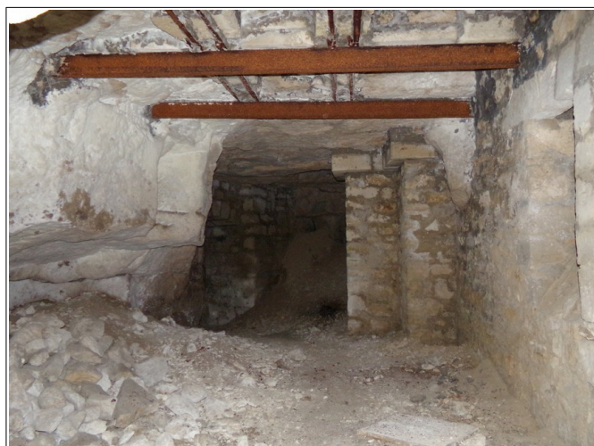
Figure XI.6: salle 2. La partie centrale présente une voûte maçonnée supportée par des IPN.
