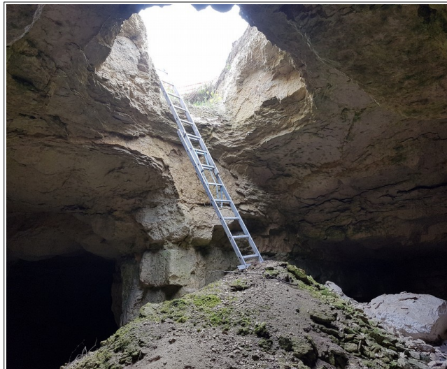
Figure III.16: effondrement localisé rue de la Dîme (cavité n°14) provoqué par le creusement des fondations d'une maison.
