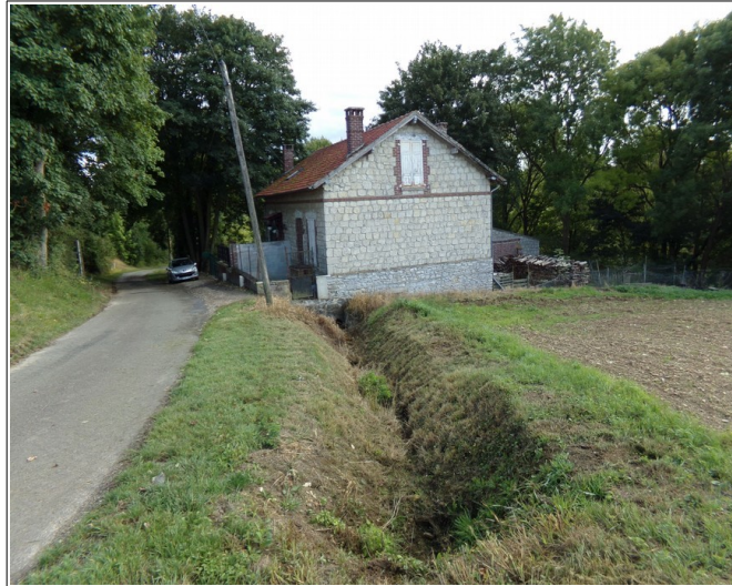
Figure III.8: quartier de Fonteneil, un fossé parallèle à la rue de Résidence Bellevue est busé sous une maison.
