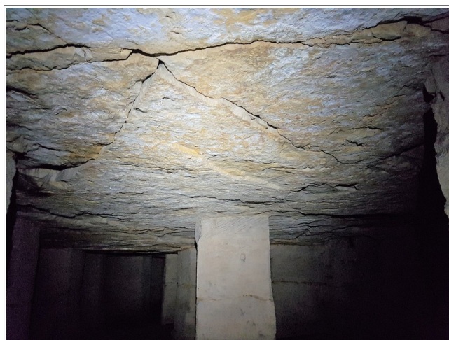
Figure V.8: extrémité nord de la salle 2. On notera la fissuration du ciel.
