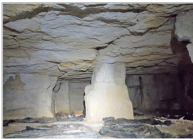
Figure XLIV.5: intérieur de la cavité (vue vers l'est). On notera l'aspect très fissuré de son ciel.
