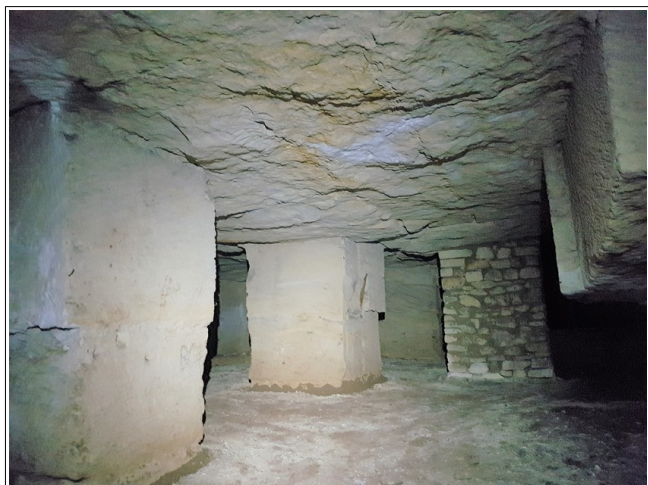
Figure XIX.7: secteur 5 de la cavité. On notera le pilier de confortement en pierres maçonnées.
