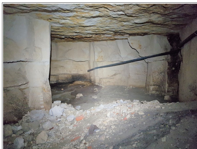
Figure XXVII.4:   rieur de la salle 2 et rejet d'eaux us es au fond de la cavit .
