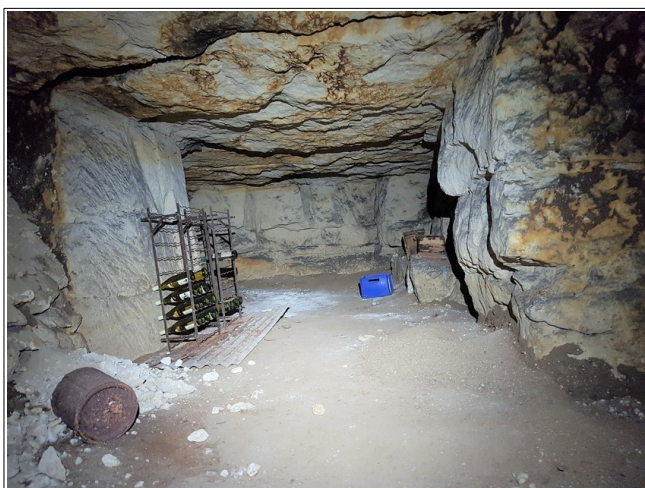
Figure XLV.9: intérieur du secteur 3. On distingue une fissure du ciel au premier plan.
