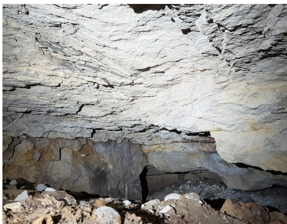
Figure XL.3: partie remblay e de la salle 1 (derri re le mur de la photo pr c dente). Le ciel de la cavit  est tr s d grad e.
