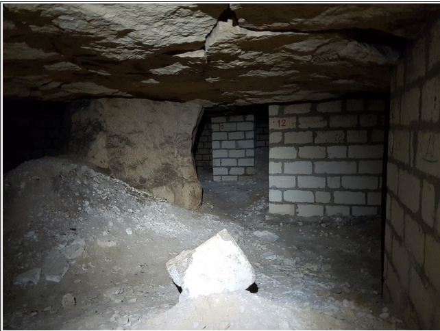
Figure VIII.9: vue de la salle 5 et de ses piliers de confortement. On notera la fissuration très prononcée du ciel au premier plan.
