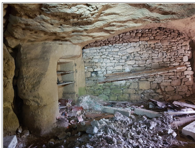
Figure XVI.4: int rieur de la cavit  16 et vue de la zone mur e la s parant de la cavit  15.
