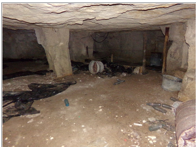
Figure XLIV.3: intérieur de la cavité (vue vers le sud-ouest). On notera le porte-à-faux du pilier.
