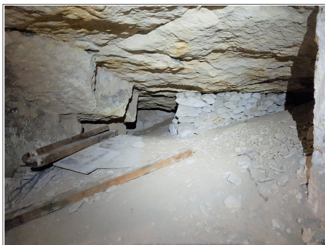
Figure XIII.4: int rieur de la salle 1 (partie situ e en bordure de la cavit  45). On notera la pr sence de remblais.
