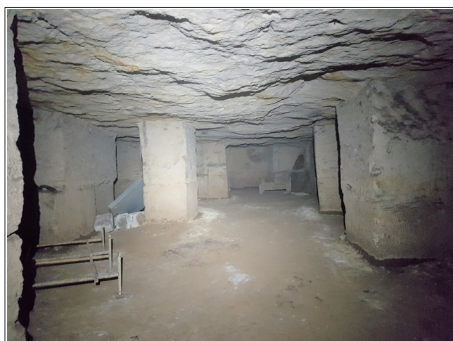
Figure XIX.4: int rieur de la cavit  au niveau du secteur 3. Le ciel est clou    ce niveau.
