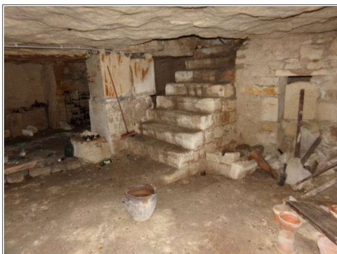
Figure XXVIII.3: intérieur de la cavité 28, on distingue l'unique pilier et le puits d'eau respectivement à gauche et à droite de l'escalier d'accès.
