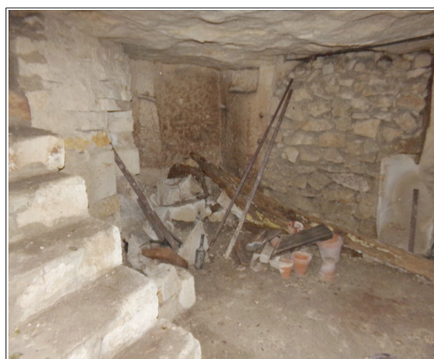
Figure XXVIII.4: intérieur de la cavité 28. La zone murée peut masquer un passage vers la cavité 14.
