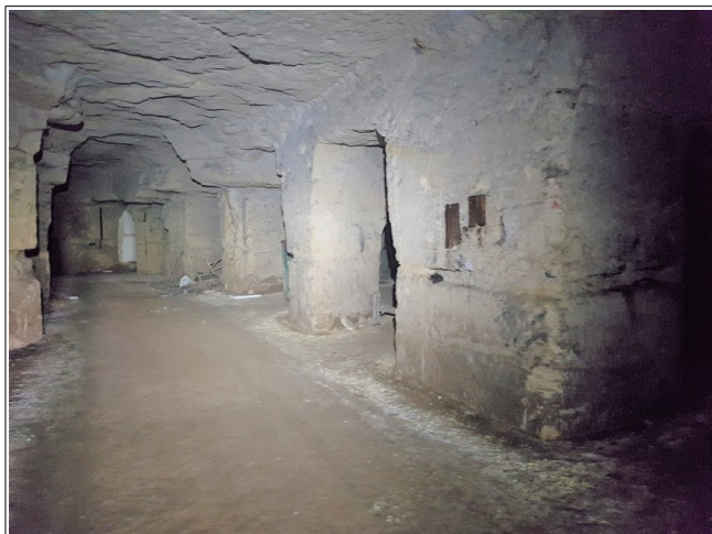
Figure XIX.3: int rieur de la cavit  au niveau de l'all e dite centrale. On notera l'alignement des piliers.
