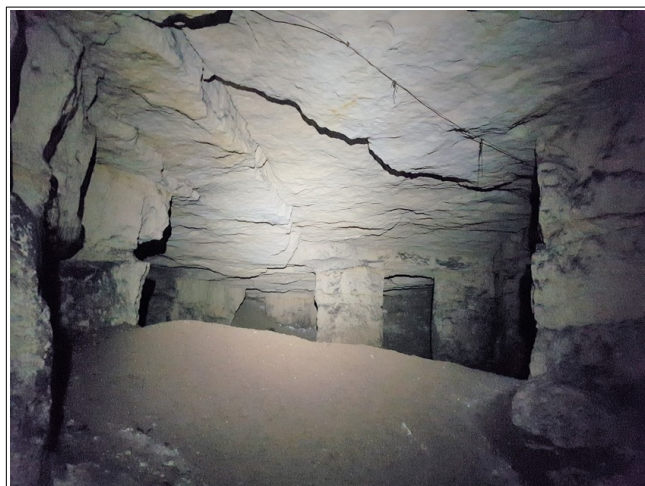
Figure XLV.10: partie ouest du secteur 2. On notera la fissure du ciel et une probable chute de toit.
