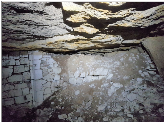
Figure VII.7: remblai stocké à l'extrémité sud de la salle 1.
