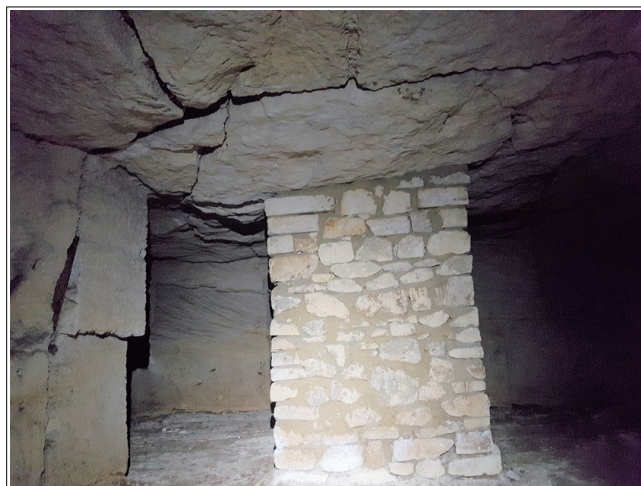
Figure XIX.8: gros plan sur le pilier de confortement du secteur 5. On notera la forte dégradation du ciel (fissures).
