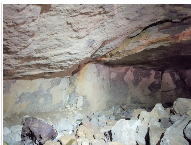
Figure L.3: int rieur de la cavit  50. Une fissure g ologique parcourt le ciel de la cavit .
