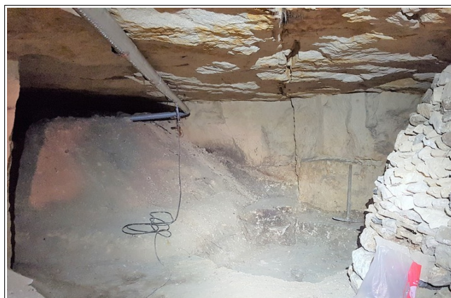
Figure XXV.5: int rieur du secteur 2. On notera la fissure g ologique parcourant le ciel et la paroi.
