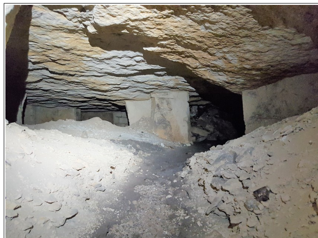
Figure XIV.5: int  rieur de la salle 2 et traces d'  coulements (rejets d'eaux us  es et pluviales).
