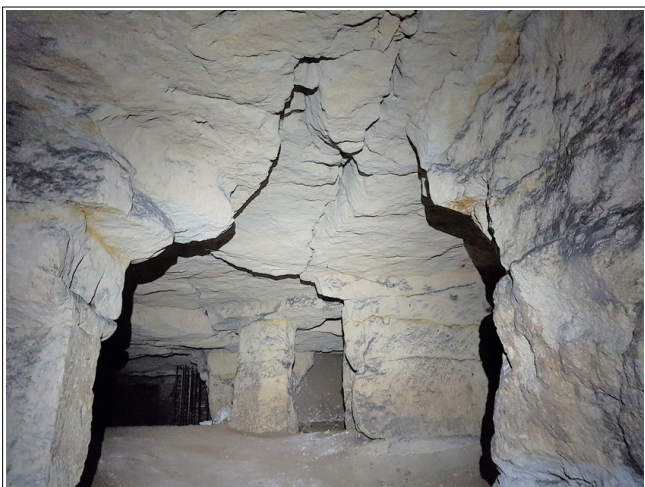
Figure XLV.11: jonction des secteurs 2 et 3. On notera la fissuration du ciel et des traces de chutes de toit. En arrière plan on distingue un remblai comblant une ouverture qui se situait sur la parcelle 206.
