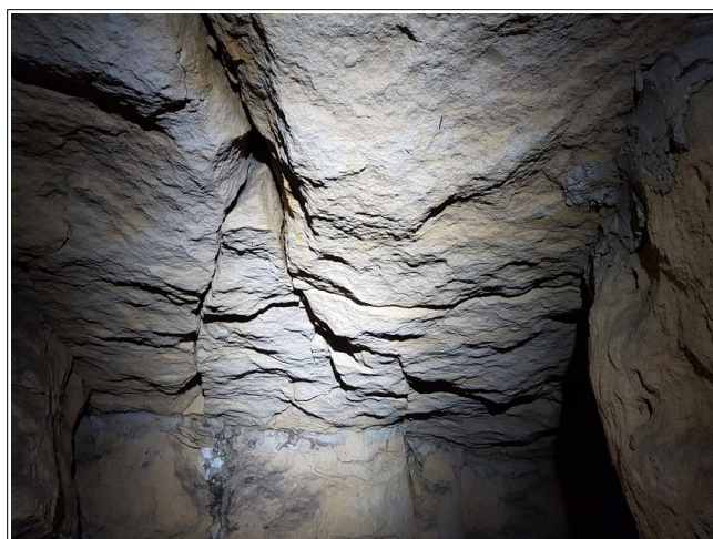
Figure XII.4: exemple de fissuration géologique du ciel dans la salle 1.
