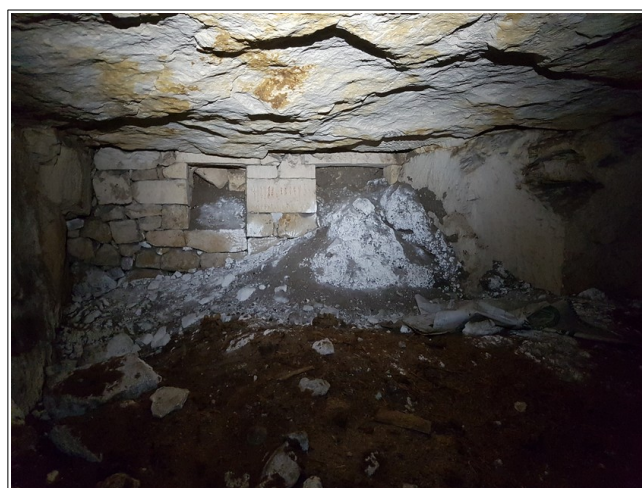
Figure VII.4: probable ancienne entr e condamn e (zone remblay e depuis la surface derri re le mur).
