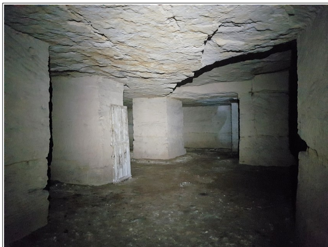
Figure V.7: extrémité nord de la salle 2. On distingue la trace d'une chute de toit à droite de la photo.
