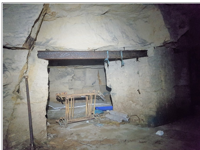
Figure XIX.5: IPN mis en place au niveau d'une zone fissur e m caniquement (secteur 4).
