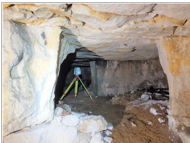
Figure VII.8: ciel localement plus fissuré dans la partie centrale de la salle 1.
