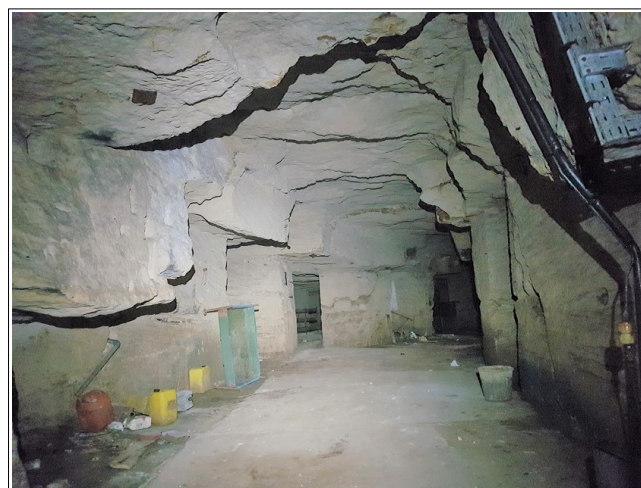
Figure XIX.10: partie centrale de la cavité entre les secteurs 3 et 4, avec présence de traces pouvant correspondre à d'anciennes chutes de toit. En haut à gauche, un clou conforte le ciel.
