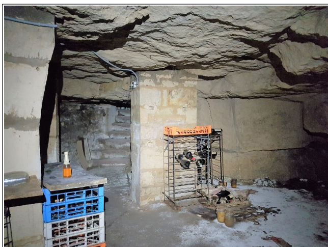
Figure XLII.6: int rieur du secteur 2. On distingue le pied de l'escalier provenant de l'int rieur de la maison. On notera  galement les piliers ma onn s.
