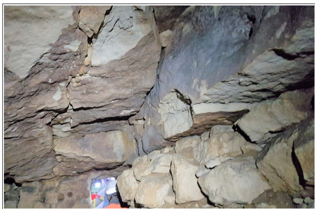
Figure XXXV.5: forte d stabilisation du ciel de la cavit    la jonction des salles 1 et 2 (d crochement). Le mur visible   droite soutient le toit.
