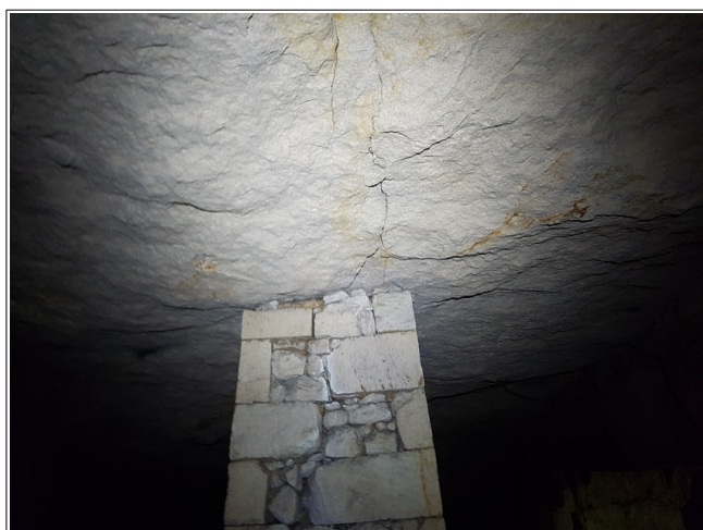
Figure IX.5: pilier en pierres ma onn es, pr s de l'extr mit  nord de la salle 2, construit au niveau d'une fissure m canique du ciel.
