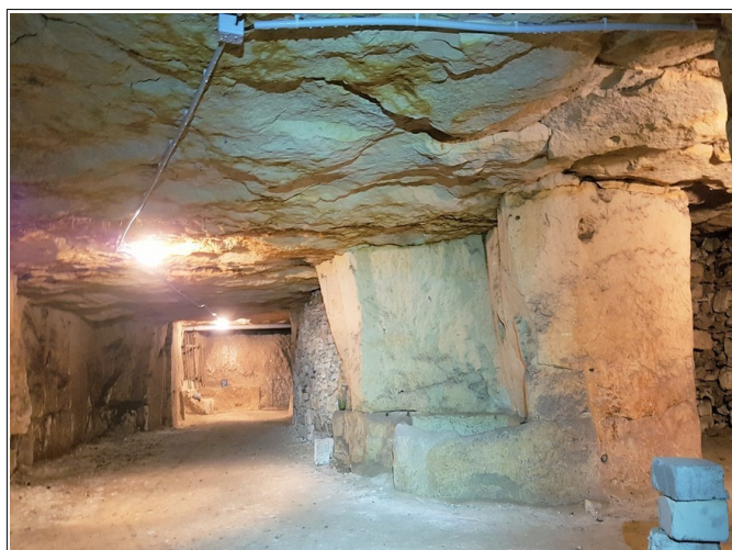
Figure XXV.3: int rieur du secteur 1 (vue en direction du secteur 2). On notera la fissuration plut t dense du ciel. Derri re le pilier, des remblais sont stock s jusqu'au niveau du ciel.
