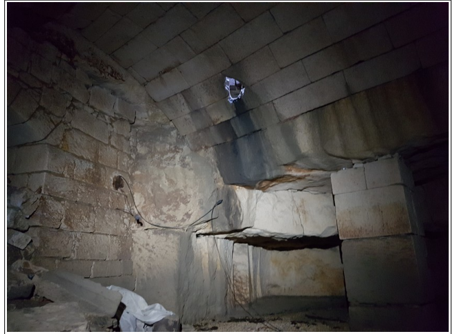
Figure VIII.8: salle 3, gros plan sur la partie voûtée donnant sur l'extérieur. On distingue également une ouverture par laquelle s'écoulent des eaux pluviales.
