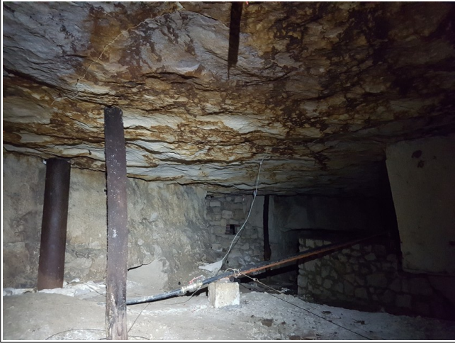
Figure VIII.7: gros plan sur le pieu et les poteaux de soutènement en bois sous l'annexe de la ferme. On notera la fissuration du ciel.
