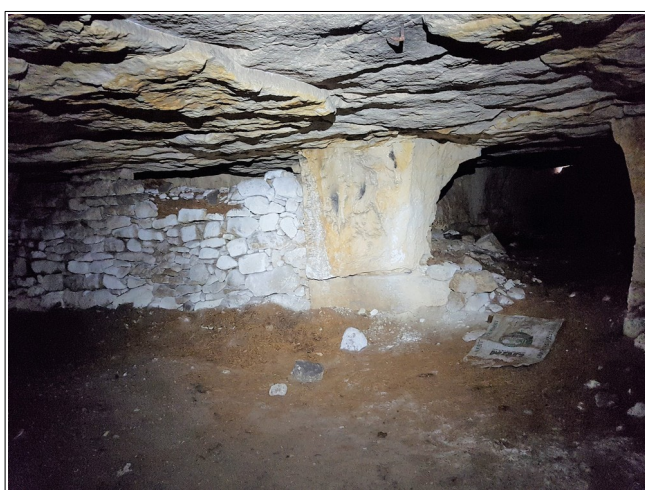
Figure VII.5: extr mit  sud de la salle 1 (zone de fortes port es). Au centre de la photo, on distingue l'unique pilier de la cavit  en partie tronqu .
