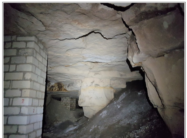
Figure VIII.12: partie centrale de la salle 6. On distingue des piliers de confortement et des remblaiements condamnant des ouvertures.
