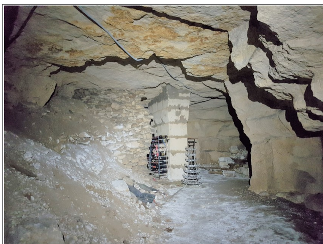
Figure XLII.3: int rieur du secteur 1. on notera le mauvais  tat du ciel. On distingue  galement l'un des piliers ma onn s de la cavit .
