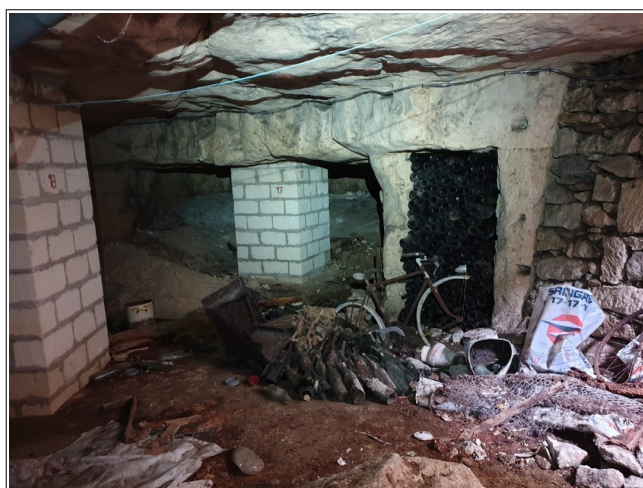
Figure X.2: vue de la salle 1 depuis le puits d'acc s. On notera la pr sence de piliers ma onn s.
