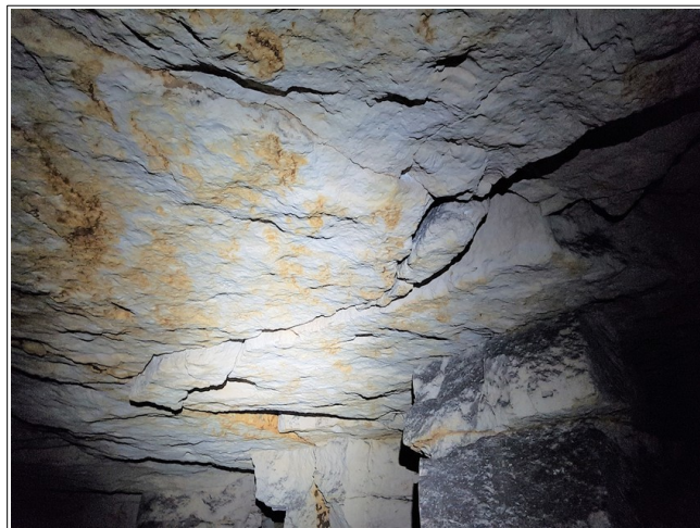
Figure XLV.8: forte fissuration géologique et mécanique du ciel et décollement dans le même secteur que précédemment.
