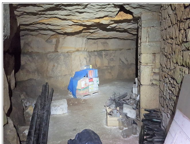
Figure XXXIII.1: intérieur de la salle 1. On distingue à droite le pilier en pierres jointées avec de la terre soutenant le toit, ainsi qu'un cloisonnement.
