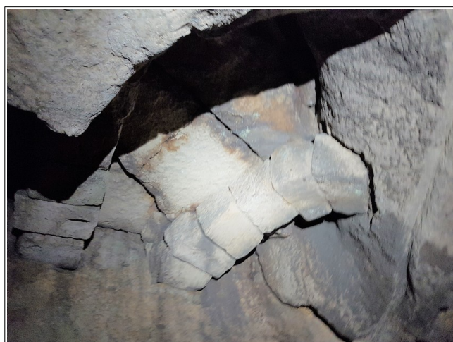
Figure XV.4: puits ferm    l'aide de pierres de taille.
