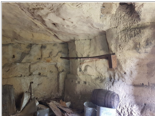
Figure XVII.3: vue de la cavit  17. On distingue une fissure au niveau du ciel. On notera  galement le petit puits de jour ferm .
