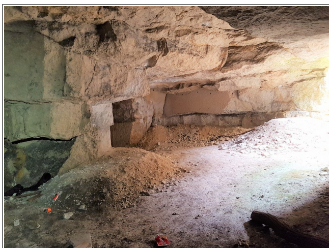
Figure XIV.3: int  rieur de la salle 1 avec traces de chutes de toit anciennes.
