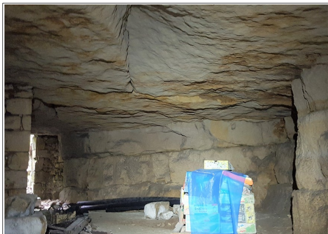
Figure XXXIII.3: intérieur de la salle 1. On notera la fissuration du ciel.
