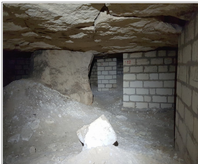
Figure III.17: piliers maçonnés de confortement de la cavité n°8, sous la rue de la Croix Rebours.
