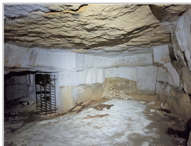
Figure XXXI.6: intérieur du secteur 2; la partie brune de la voûte coïncide avec la zone de décollement.
