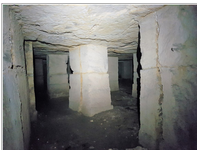
Figure V.6: vue de la salle 2 (bordure centre-ouest) avec pr sence de piliers fissur s g ologiquement.
