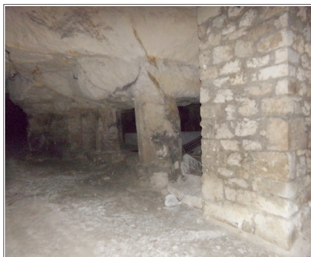
Figure XXI.2: intérieur de la cavité 21 près de l'entrée. On notera le pilier maçonné (renfort).
