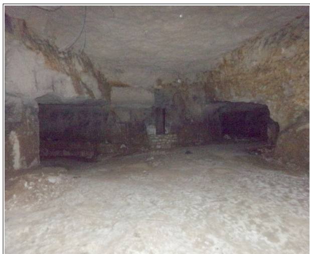
Figure XXI.3: intérieur de la cavité 21. Les portées et le taux de défrètement sont importants.
