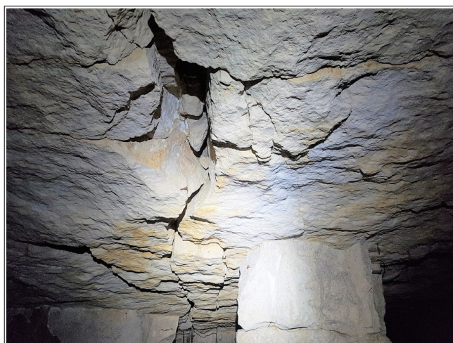
Figure XLIV.6: forte fissuration du ciel au niveau du pilier.
