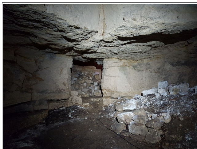
Figure I.3: intérieur de la salle 2. On notera la fissure géologique parcourant le ciel. En arrière plan, la communication vers la salle 1.
