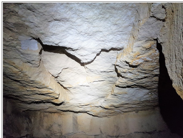
Figure XXXVII.4: trace de chute de toit ancienne vers le fond de la cavit .
