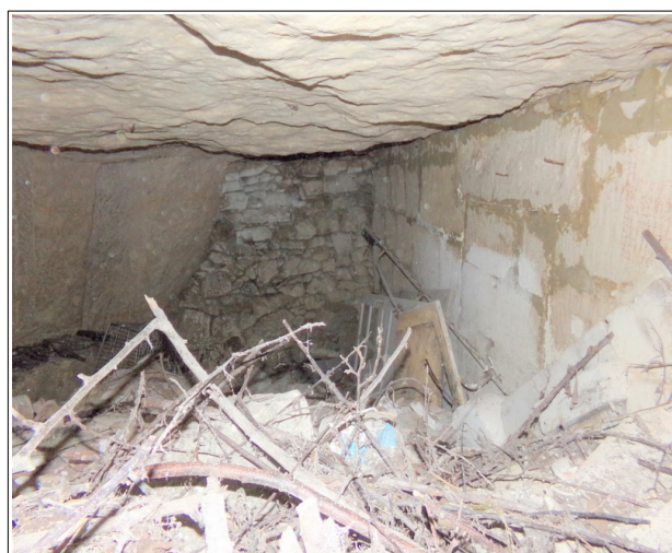
Figure XL.2: int rieur de la salle 2. La zone mur e visible en arri re plan contient un remblai obstruant une extension sous la place de la D me.
