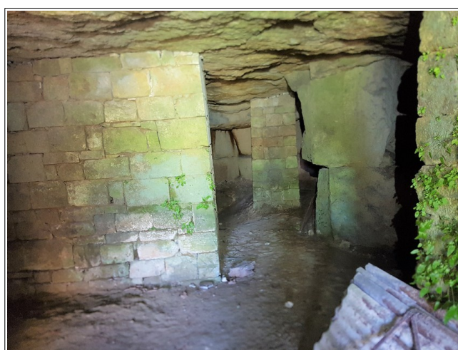
Figure XLVI.2: int rieur de la salle 1. On distingue 2 des 4 piliers de confortement.
