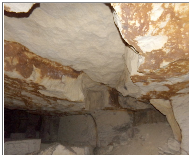
Figure XXIII.4: chute de toit au fond de la cavit .
