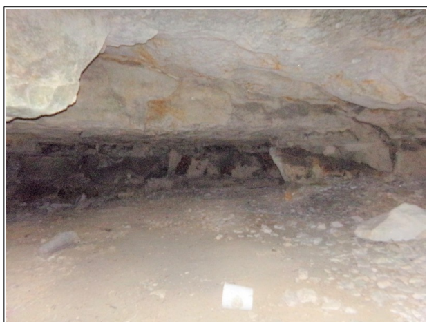
Figure XXXVIII.3: intérieur de la cavité 38. On notera sur la droite de la photo le bloc au sol qui correspond à une chute de toit.
