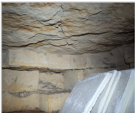
Figure XXXIII.5: fissuration mécanique du ciel de la salle 2.
