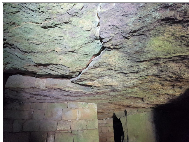
Figure XLVI.3: ciel fissur  m caniquement et d collement pr s de l'entr e (salle 1).
