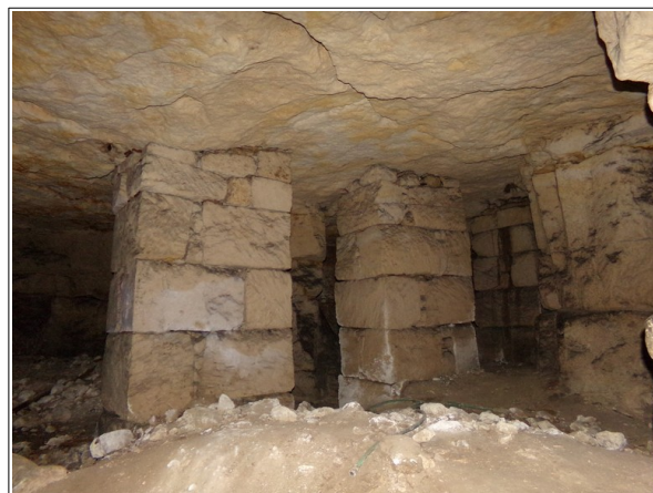
Figure XLV.3: piliers de confortement dans un recoin du secteur 2 (sous l'habitation).
