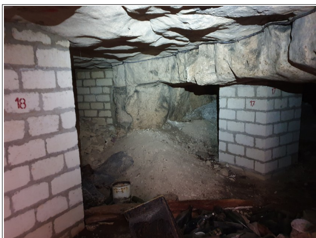
Figure X.3: vue g n rale de la salle 1. On notera les piliers ma onn s et une zone mur e au fond en direction de la parcelle 131.
