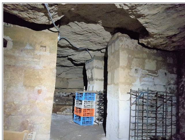
Figure XLII.5: int rieur du secteur 2 et piliers ma onn s sous la maison. On notera l' tat d grad  du ciel.
