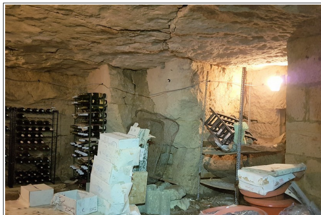
Figure XXXIV.2: int rieur de la cavit  34. On notera la fissuration du ciel.
