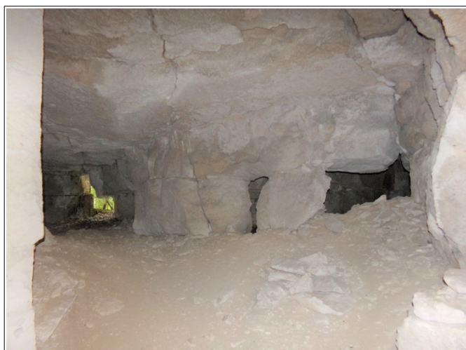
Figure XLI.3: int rieur de la cavit  41. On notera la fissuration du ciel et le pilier en arri re plan.
