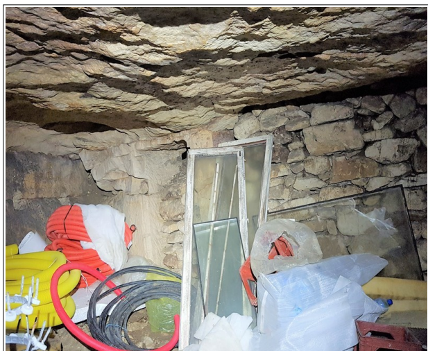
Figure XXXV.3: int rieur de la salle 1. Le mur en pierres s ches contient un remblai au nord de cette salle. A l'origine la cavit  pouvait s' tendre vers la place de la D me   partir de ce point.
