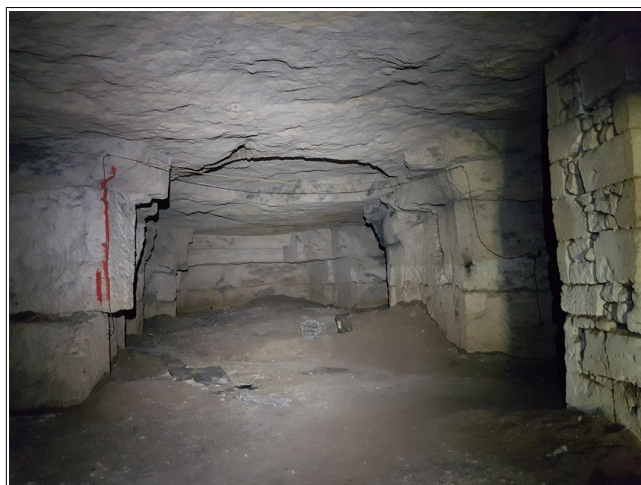
Figure IX.4: int rieur de la salle 2 (pr s de l'extr mit  nord). On notera le pilier en pierres ma onn es   droite et une probable trace de chute de toit au centre.
