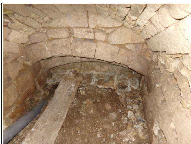
Figure XXIX.2: acc s   la cavit  condamn e. On notera la pr sence d'un tuyau en PVC d' vacuation d'eau.
