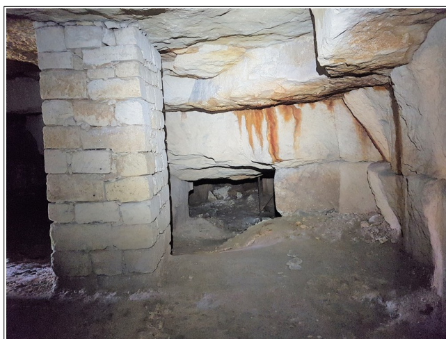
Figure XLVI.4: int rieur de la salle 1 et vue de la salle 2 en arri re plan. On notera les traces d'infiltrations et le d crochement au plafond pouvant correspondre   d'anciennes chutes de toit.
