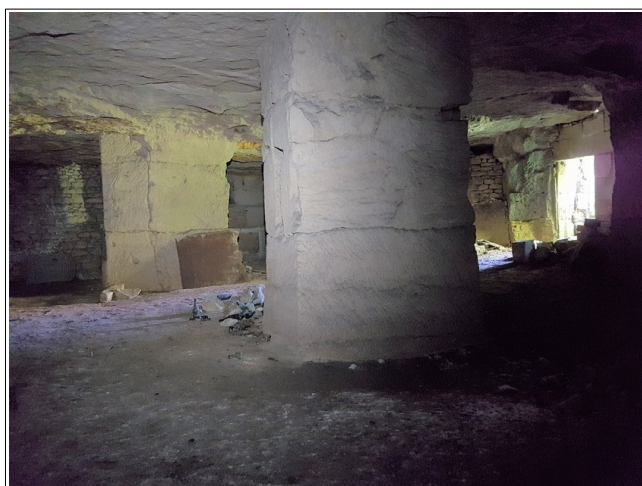
Figure V.2: vue g n rale de la salle 1. Une fissure g ologique est visible sur le pilier en arri re plan.
