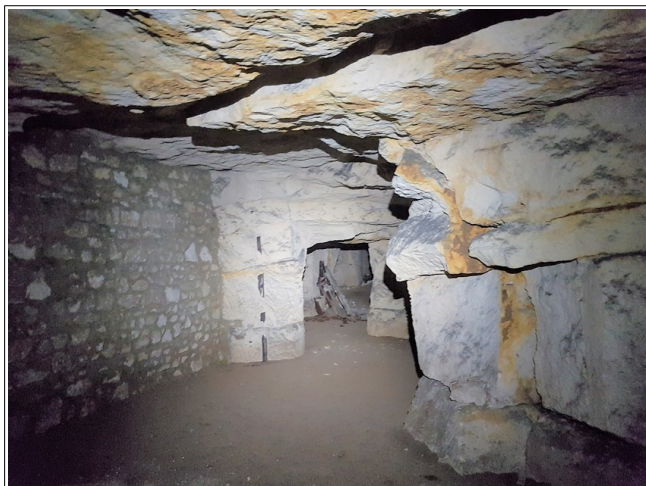
Figure XLV.7: zone murée sur la bordure ouest du secteur 4. L'ombre visible au plafond souligne un décollement comprimant un pilier.
