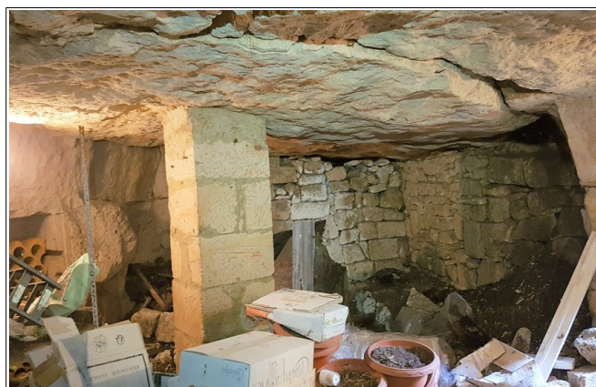
Figure XXXIV.4: pilier ma onn  soutenant un d crochement du ciel de la cavit . En arri re plan le mur peut condamner une extension vers la place de la D me (extr mit  sud de la cavit ).
