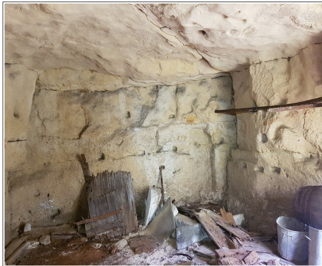
Figure III.14: exemple de petite carrière artisanale à chambre unique (cavité 17).
