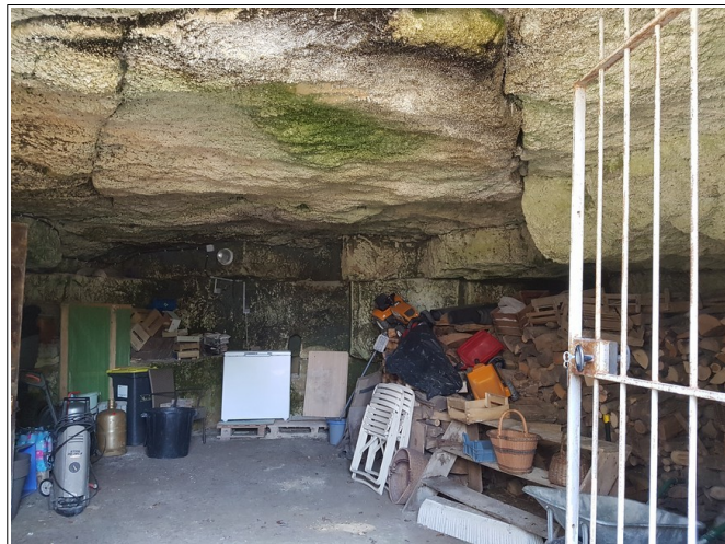
Figure XVIII.1: int rieur de la salle 1. On notera la fissuration g ologique du ciel.
