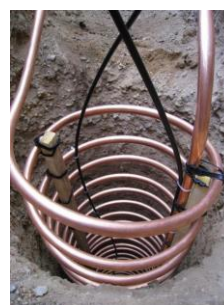
Figure 30. Capteurs horizontaux (BRGM) et échangeurs compacts (AFPG)
