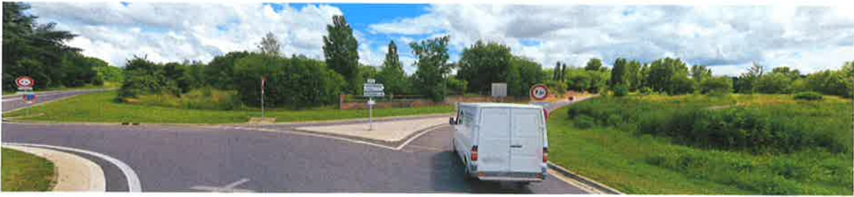
Vue depuis l'échangeur de la RN2 venant de Crépy-en-Valois
