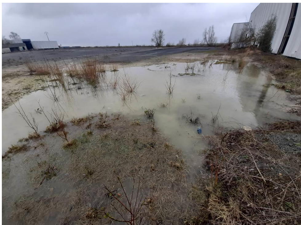
Figure 18 : Zone de stagnation d'eau au pied du hangar Ouest
