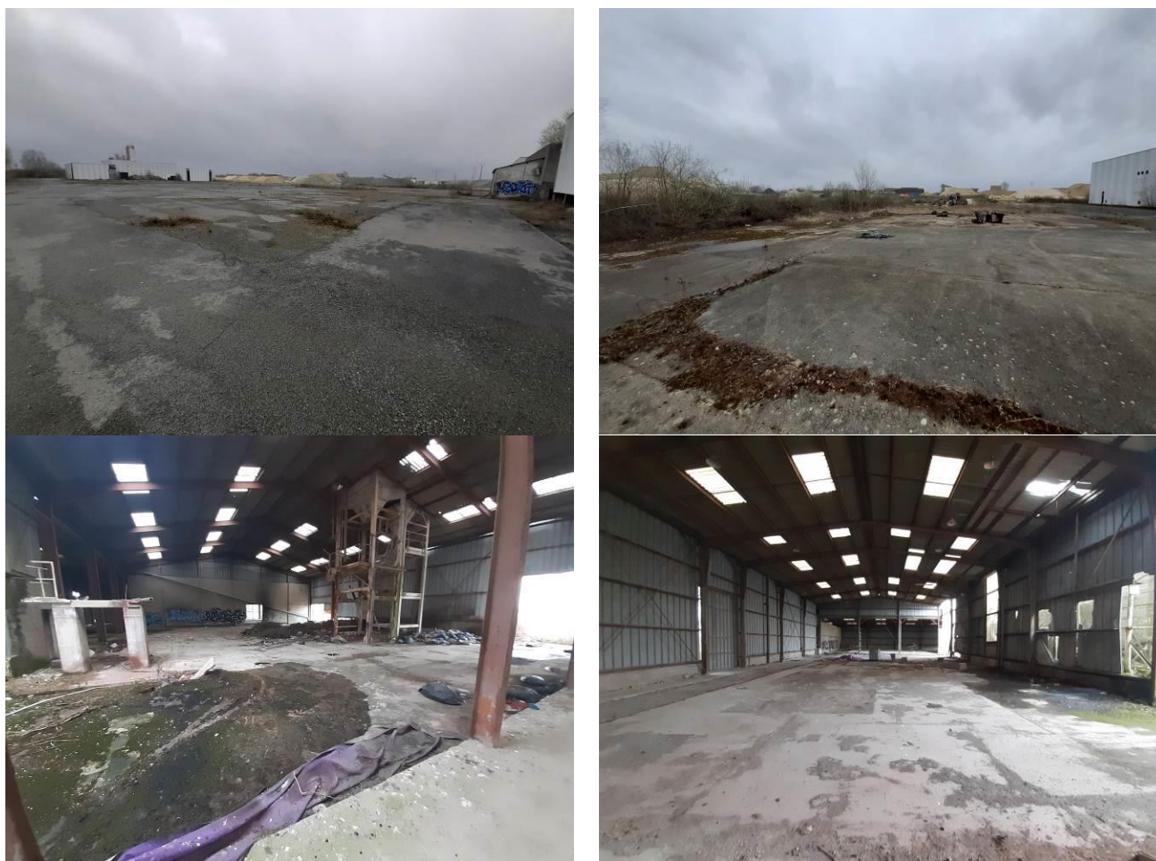
Figure 11 : Vues du site et de l'intérieur des hangars
