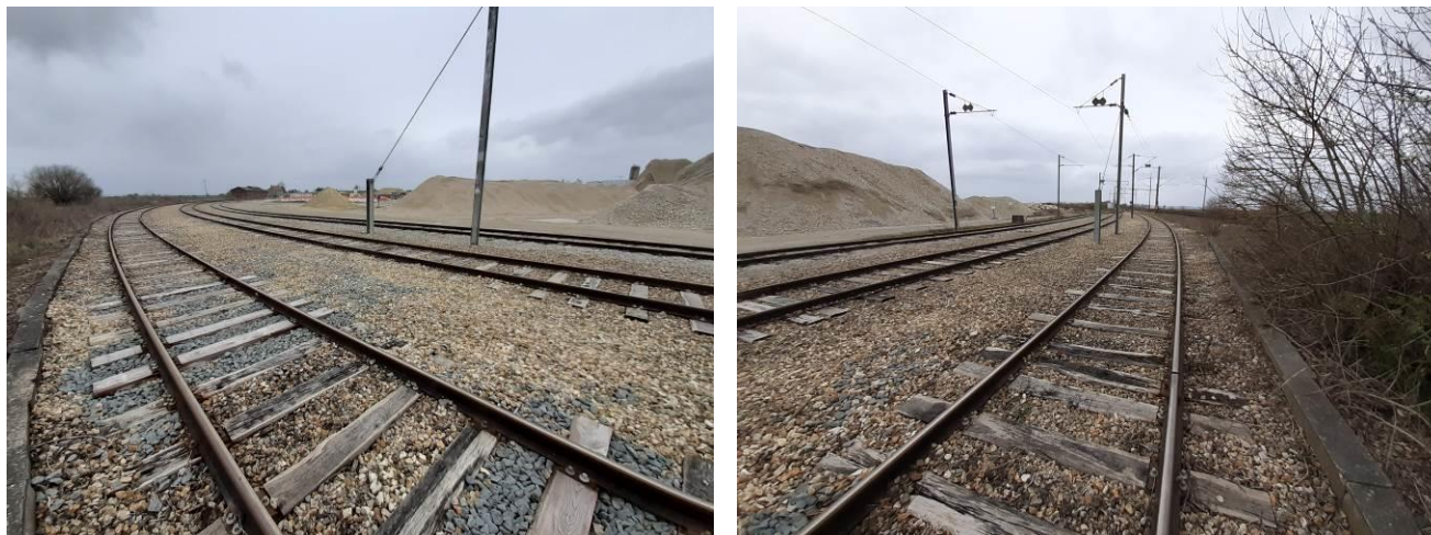
Figure 13 : Voies ferrées en limite nord-ouest
