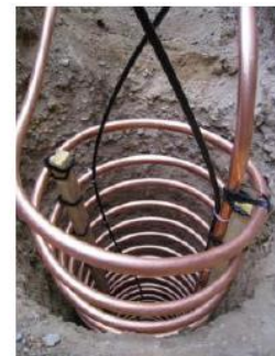
Figure 24 : Capteurs horizontaux (BRGM) et échangeurs compacts (AFPG)
