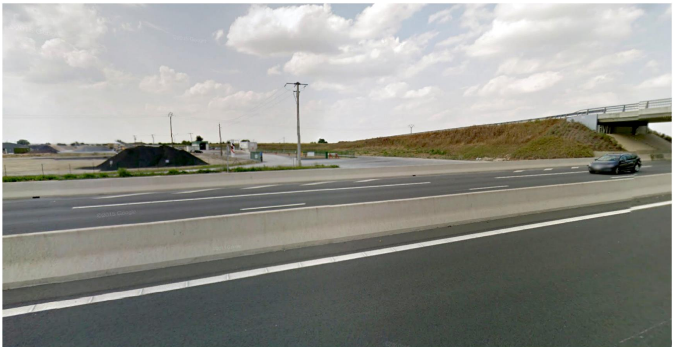
Figure 41 : Vue proche depuis le RN2 en venant du Sud (au niveau de l'échangeur)
