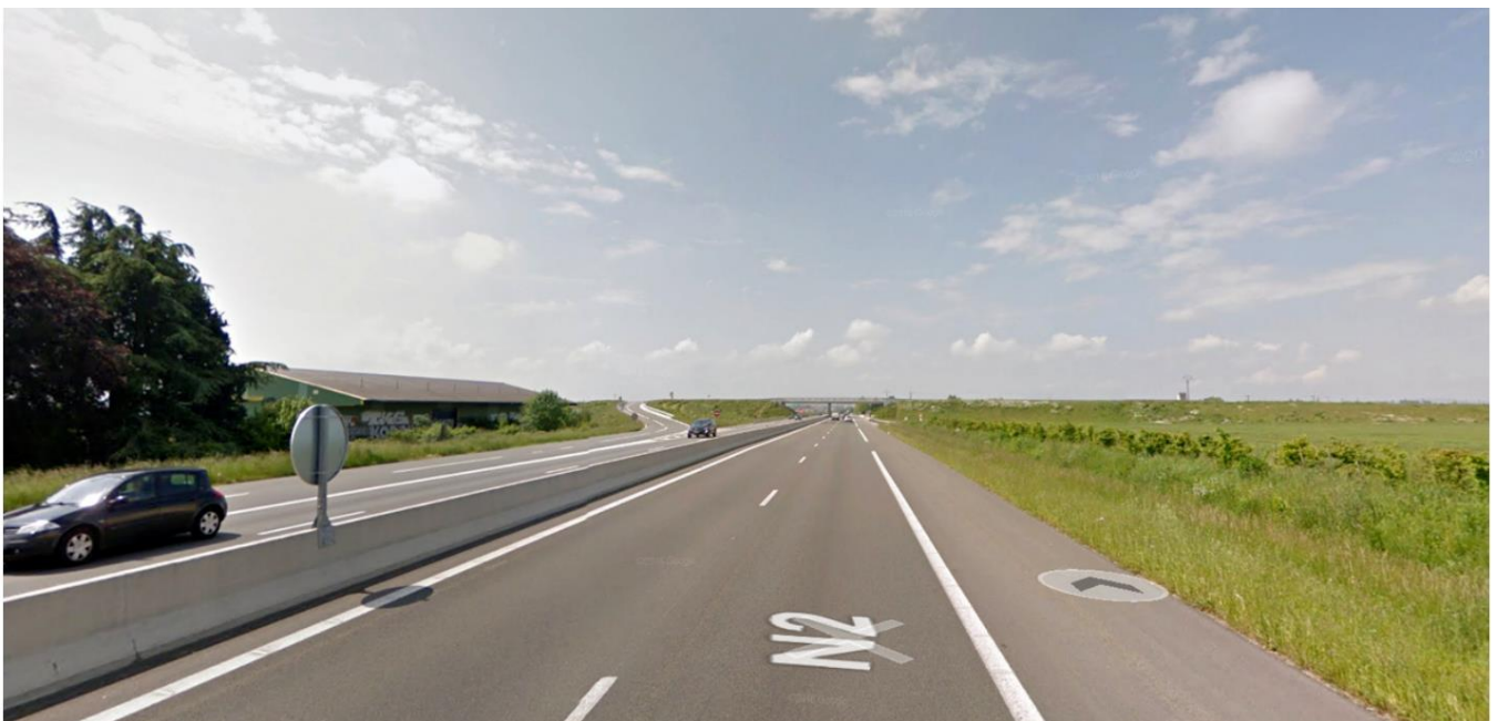
Figure 43 : Vue depuis le RN2 en venant du Nord (à l'approche de l'échangeur)
