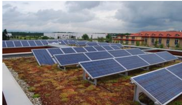
Toiture végétalisée et panneaux solaires
