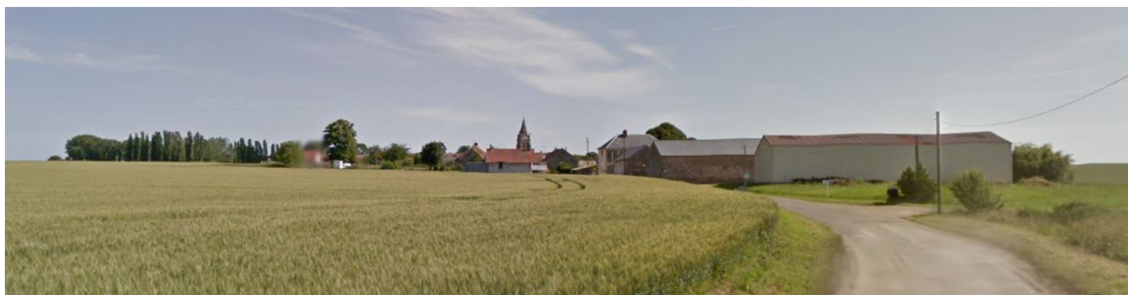
Entrée sud par la RD18/rue des Tilleuls : vue sur le patrimoine bâti ancien de l'église et du corps de ferme
