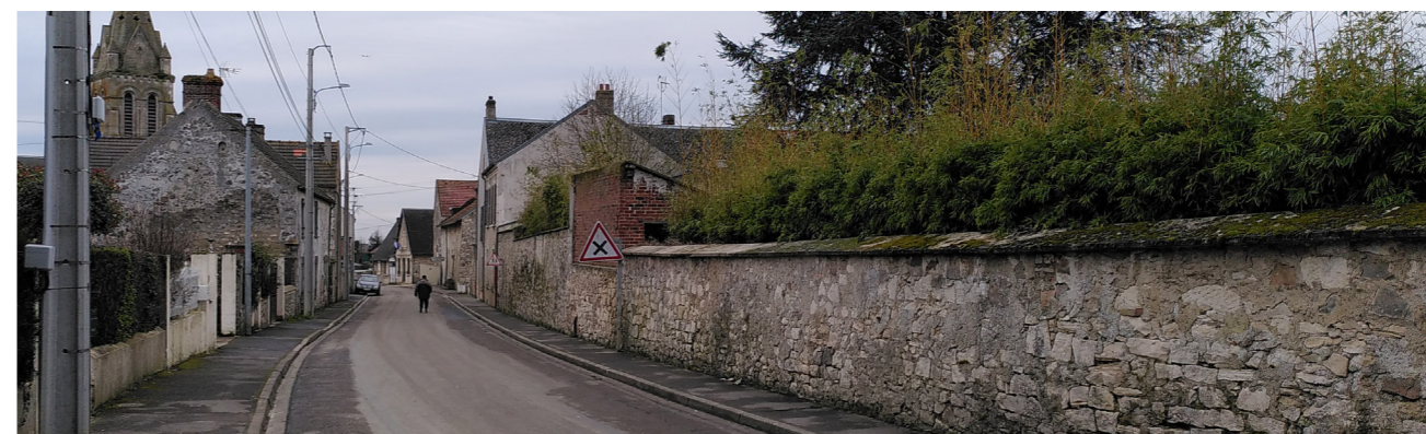
Mur en pierres rue des Tilleuls
