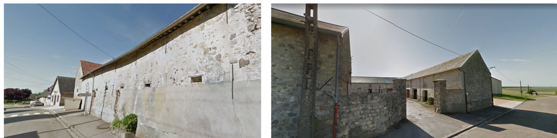
Sièges d'exploitation en activité : corps de ferme au 14 rue des Tilleuls (proche de la mairie) et corps de ferme en entrée sud du bourg au 1 rue des tilleuls
