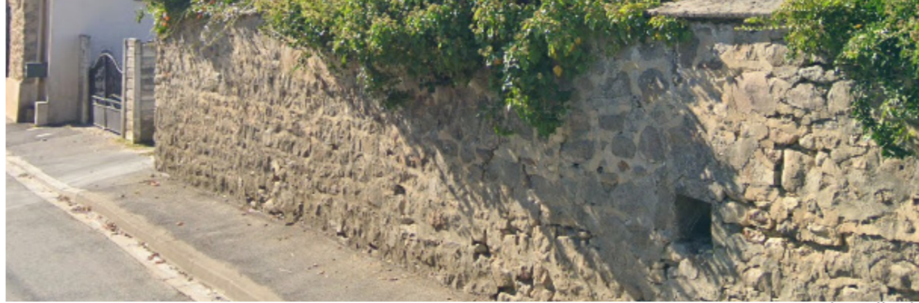
Mur en pierres rue des Tilleuls
