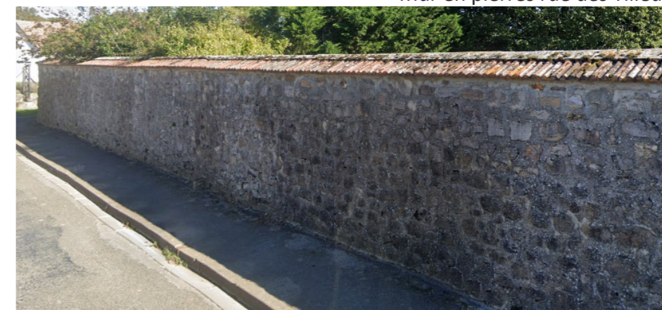
Mur en pierres rue des Tilleuls
