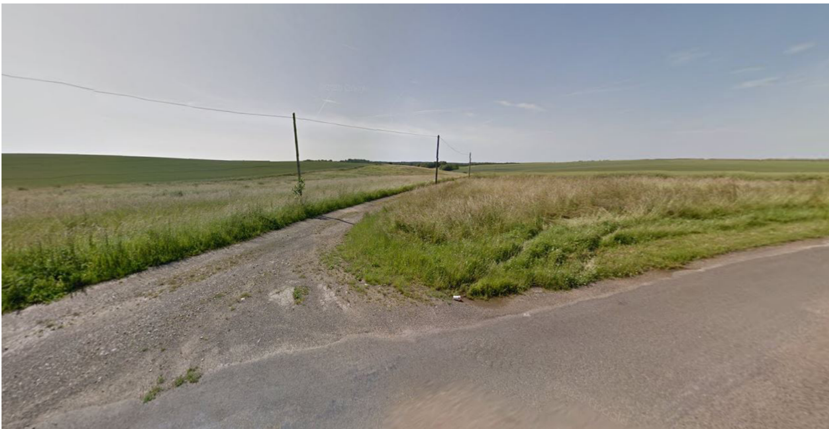
Chemin rural d'Étavigny à Rosoy-en-Multien : talweg recueillant les eaux pluviales du plateau agricole vers la vallée de la Gergogne.
