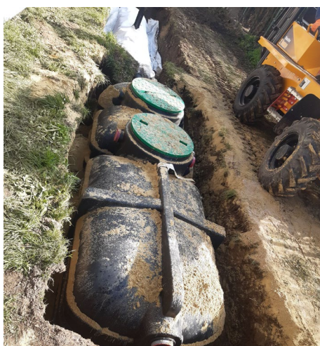
Assainissement non collectif composé d'une filière compacte et de tunnels d'infiltration
