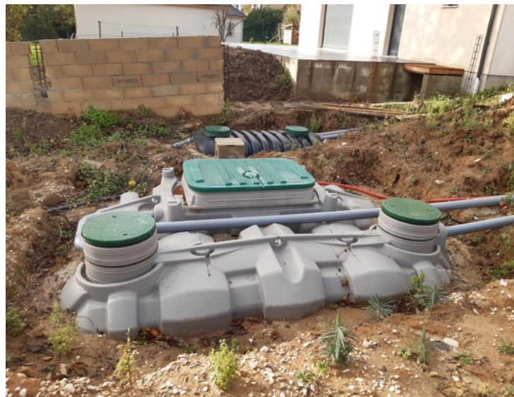
Assainissement non collectif composé d'une fosse toutes eaux d'un filtre compact
